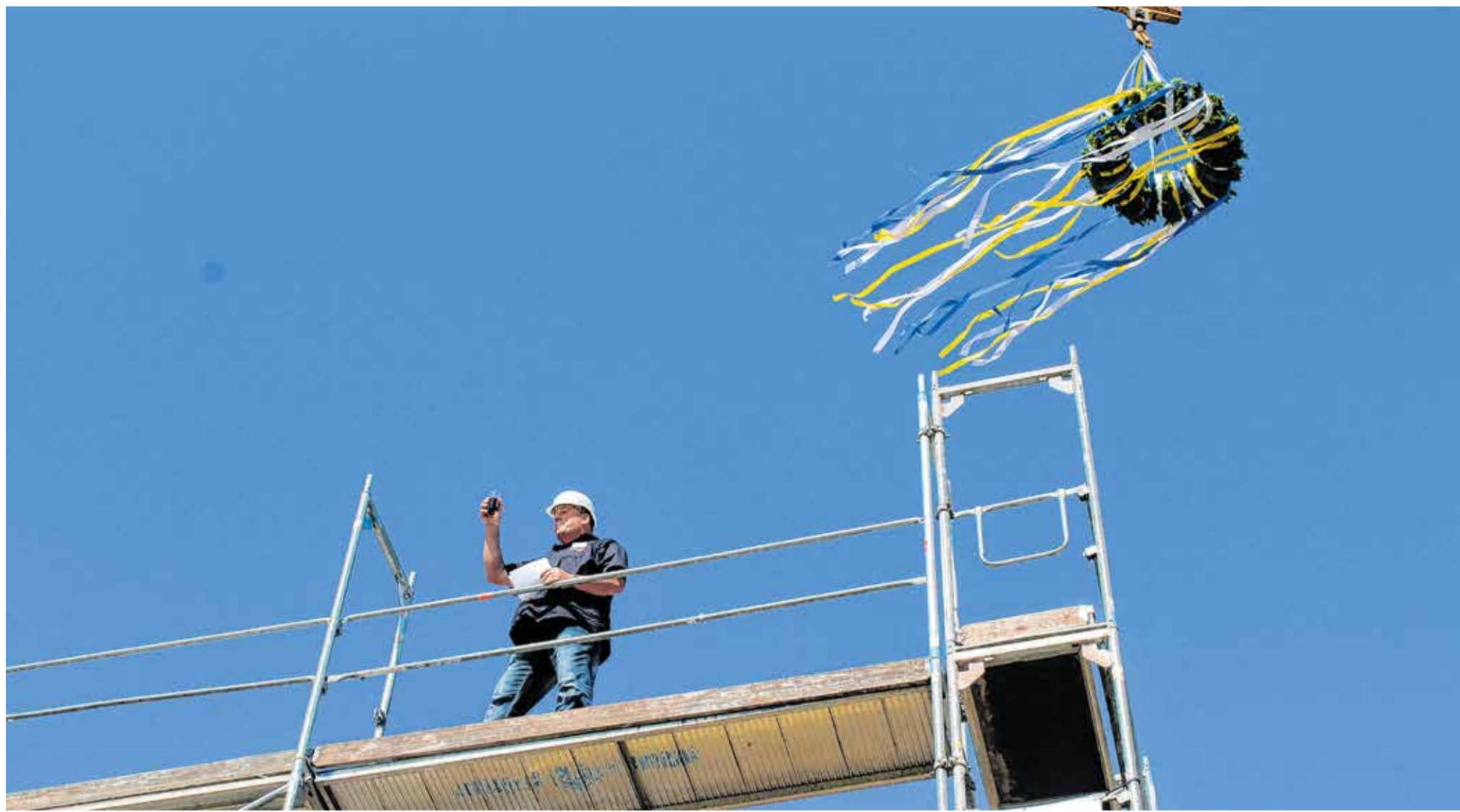
Richtfest bei der Spedition Barth im Hechinger Nasswasen. Bauleiter Werner Terbeck sagt den Richtspruch.
