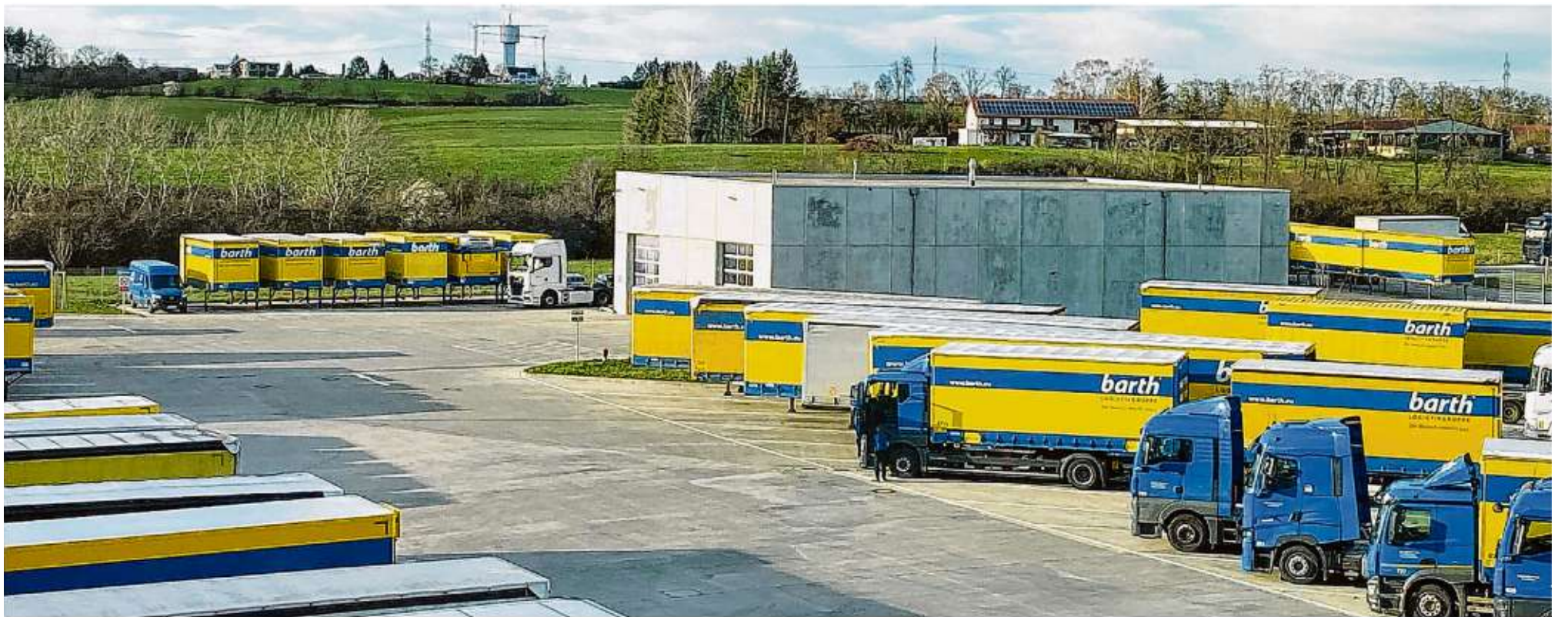
Die gelb-blaue Barth-Flotte könnte ab Mitte 2025 auch an einem 16 Meter hohen, 5000 Quadratmeter großen Medizintechnik-Logistikzentrum andocken, das auf dem Firmengelände in Richtung Sickingen (im Hintergrund der Wasserturm) gebaut werden soll. Fotos: Hardy Kromer
